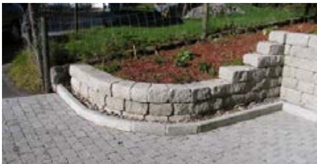
Bild 30: Maueraufbau mit SANTURO® Keilmauersteinen
