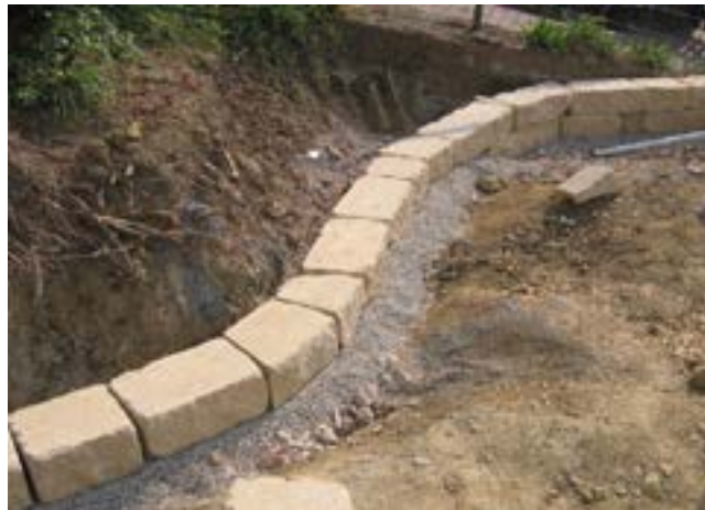
Bild 24: Versetzte erste Steinreihe in Kiesfundament
