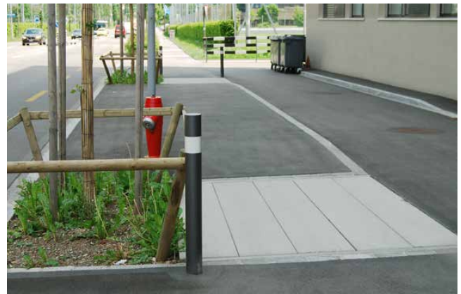
Einbau von Wurzelbrücken seitlich der Baumgrube
