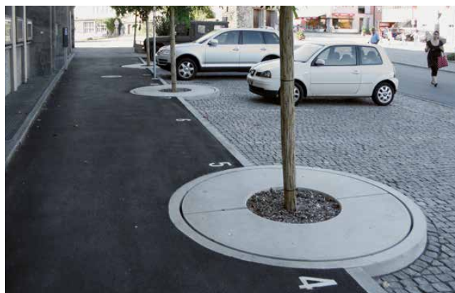
Anlegen von Hochborden
