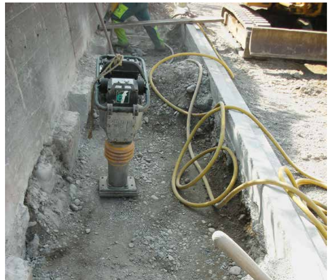
Sohle für die Versetzung der Fundamente
