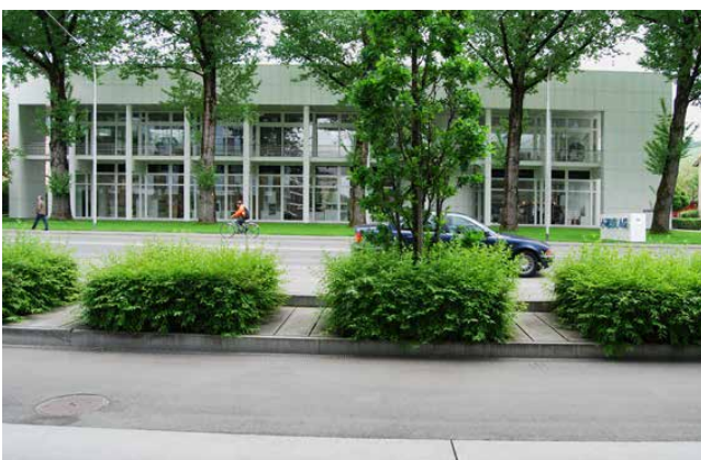
Einbau von Verbindungen zwischen den Baumgruben
