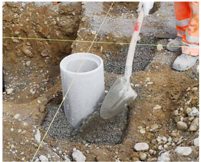
Erstellen der Punktaulager mit Betonrohren
