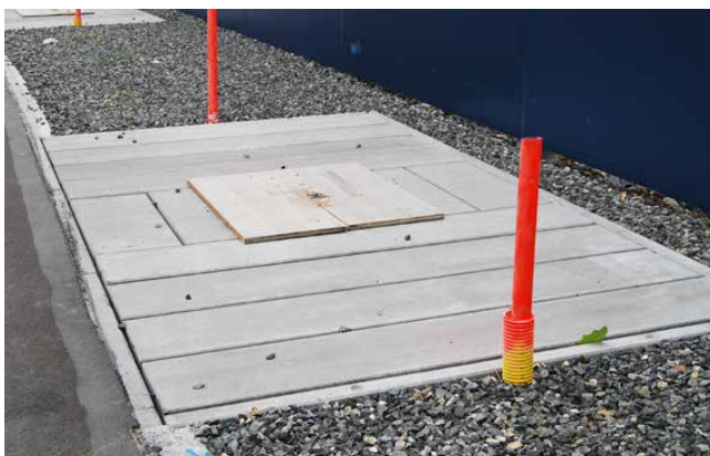
Einbau von Bewässerungs- und Belüftungsleitungen
