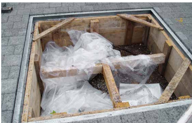
Eingebauter Stahlrahmen als Baumkranz
