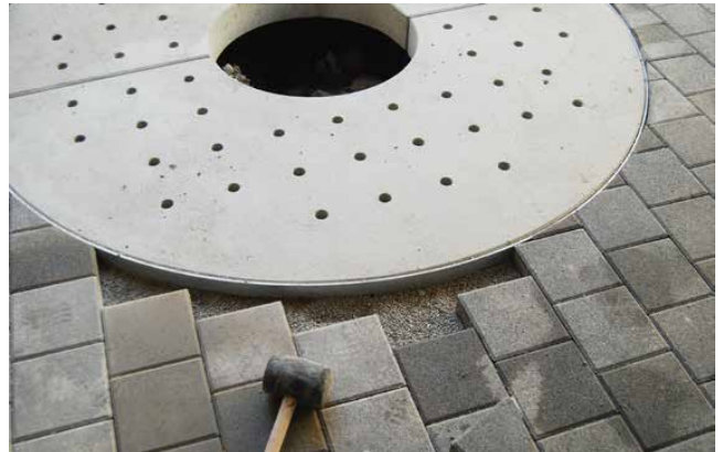
Versetzte TREETUB Betonabdeckung 2-teilig
