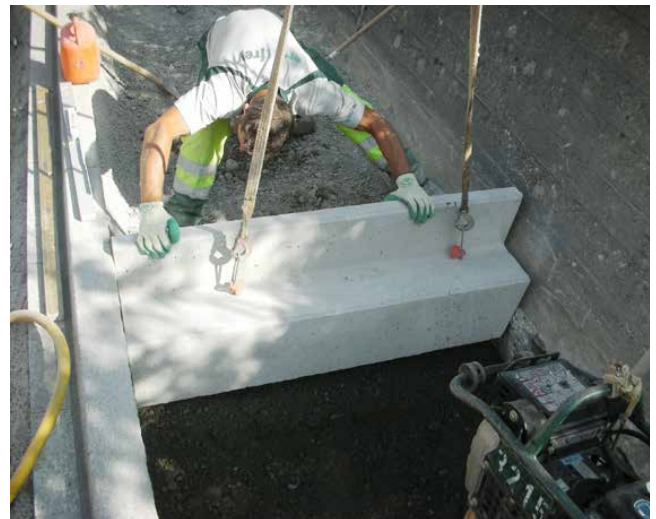
Versetzen des F+F Fertigfundamentes
