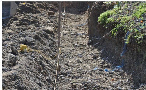
Bild 19: Aushub auf Frosttiefe
