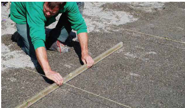
Abziehen der Bettungsschicht
