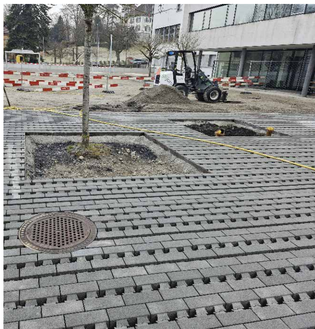
Fräsarbeiten CLIMA STONE Rasen
