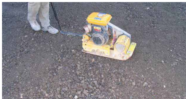
Verdichten der Fundationsschicht
