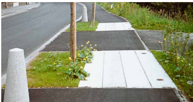
Wurzelbrücke mit Wehrsteinen als Anfahrtschutz
