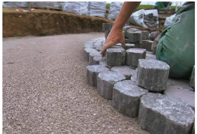
ARENA Vista® Pflastersteine werden von Hand verlegt
