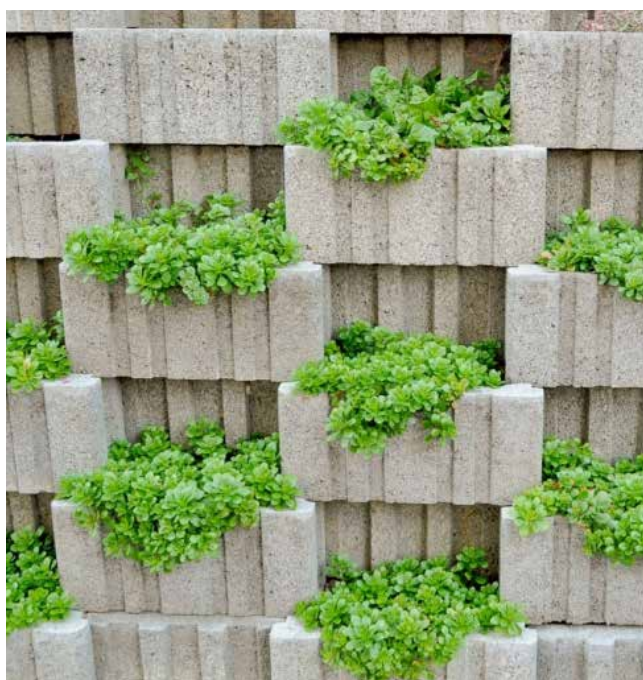
Bild 1: TERUNO® Mauer mit 68° Neigung
