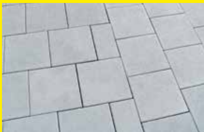
Richtungswechsel der Pflastersteine
