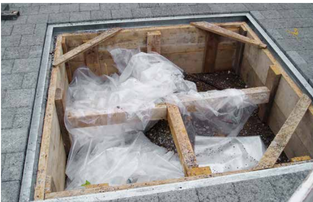
Eingebauter Stahlrahmen als Baumkranz
