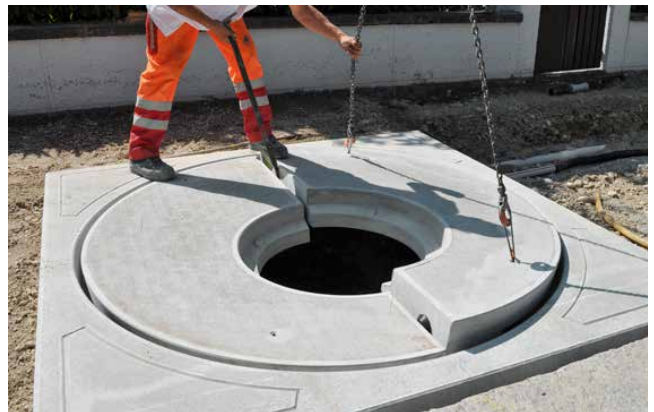
Versetzen der COPAL® Betonabdeckung
