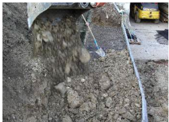
Bild 25: Hinterfüllen der zweiten 20 cm
