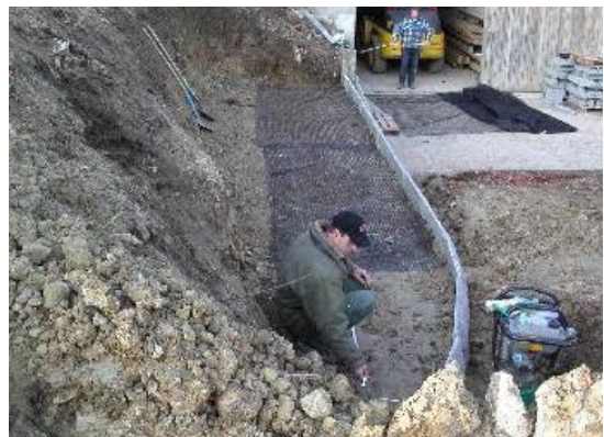
Bild 24: Verlegen der Geogitter, seitliche Überlappung 20 cm
