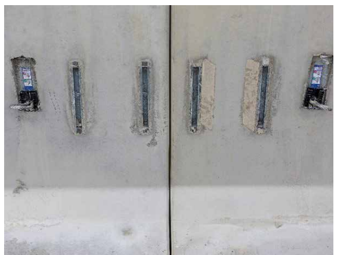
Halfenschienen als Verbindungsgrundlage
