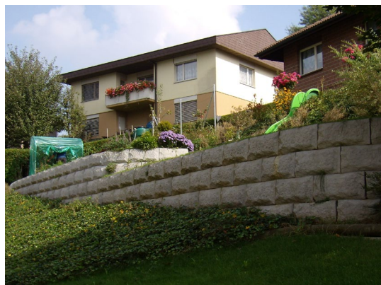
Bild 2: LOCK+LOAD im Radius
