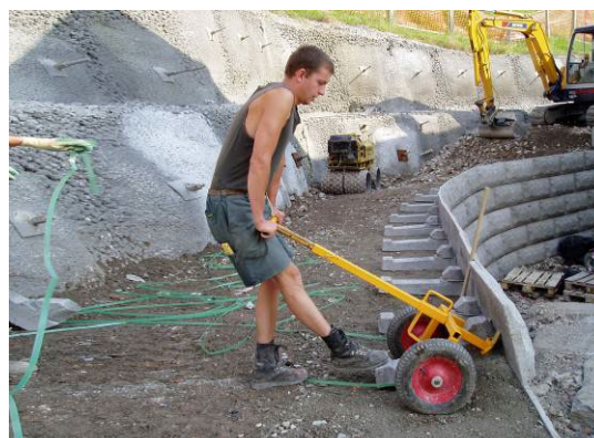
Bild 17: LOCK+LOAD Versetzwagen
