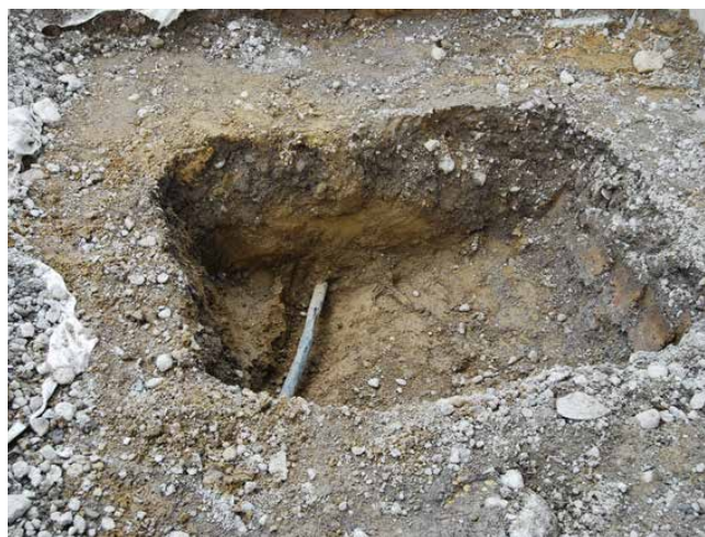
Werkleitungen stören das Wachstum der Baumwurzel
