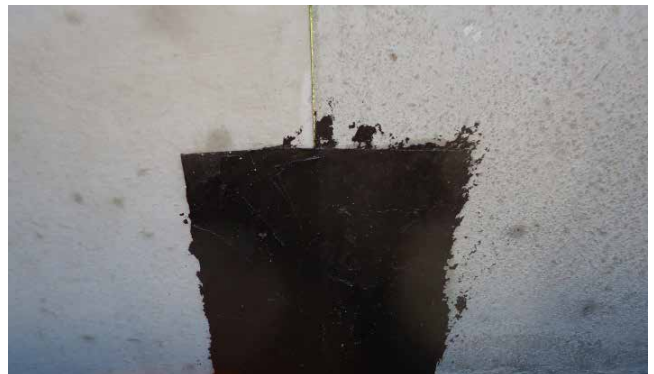
Bild 33: Abdichten der Fugen
