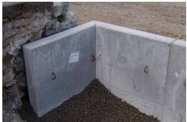
Bild 31: Versetzte Eckelemente
