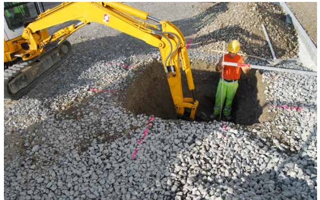
Erstellen des Pflanzloches
