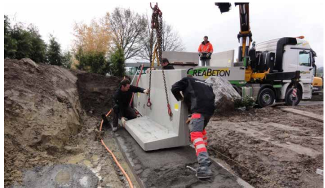
Bild 29: Versetzen der Winkelplatte auf ein Streifenfundament
