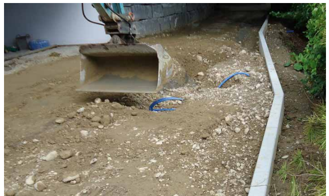
Bild 34: Lagenweises Einbringen von geeigneten Hinterfüllmaterial
