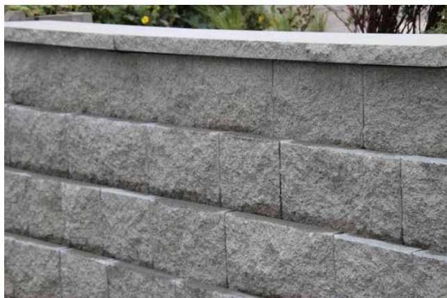
Bild 1: Geschlossener Aufbau mit Abdeckplatten
