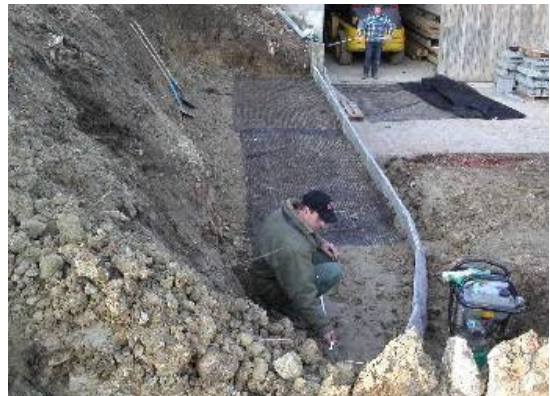
Bild 24: Verlegen der Geogitter, seitliche Überlappung 20 cm
