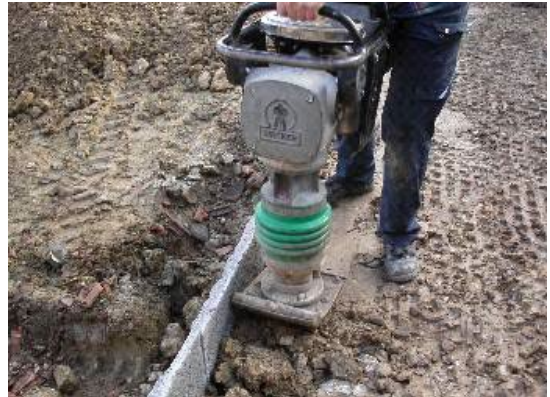
Bild 22: Verdichten mit Vibrostamper
