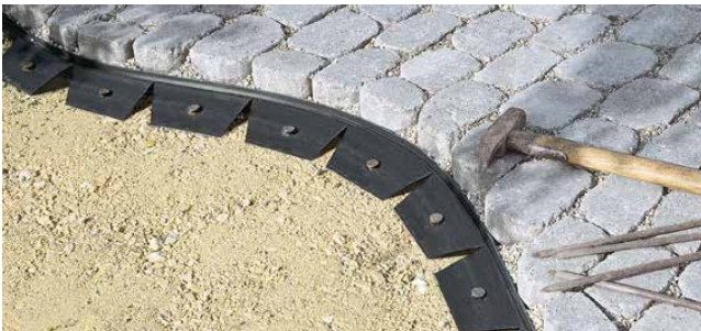
Randabschluss mit PAVE EDGE® Randschienen
