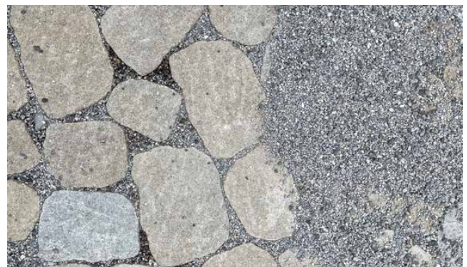
Einsanden/Einsplitten der Fugen
