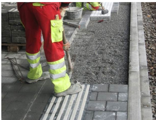
Bild 32: Herausnehmen der restlichen Steine
