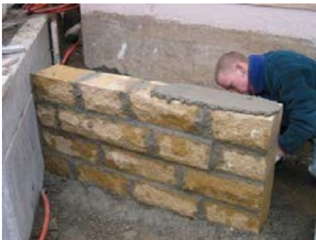
Bild 42 Aufbringen Mörtel für Abdeckplatte
