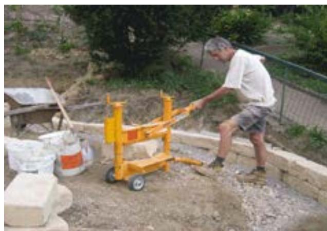
Bild 35: Arbeiten mit Steinspalter
