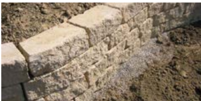
Bild 28: Kurvenbildung mit geraden Steinen
