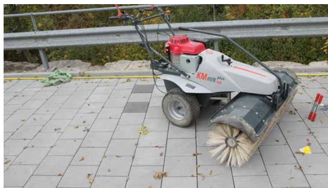
Bild 7: Einsanden der Fugen
