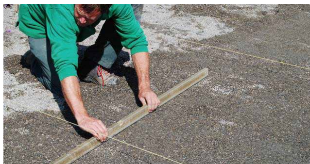
Bild 6: Abziehen der Bettungsschicht
