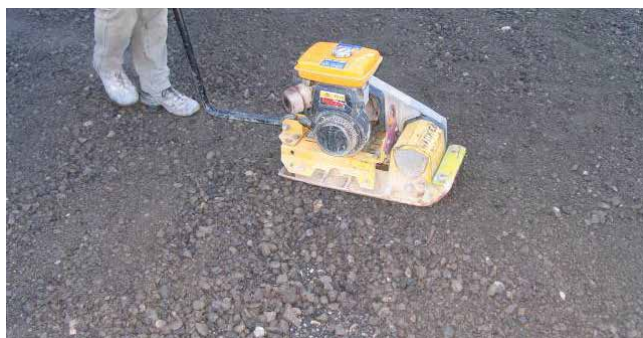
Bild 5: Verdichten der Fundationsschicht
