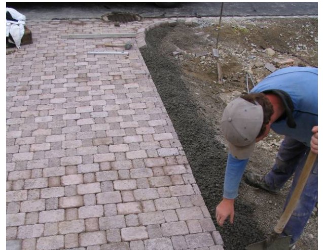
Bild 43: Erstellen des Randabschlusses
