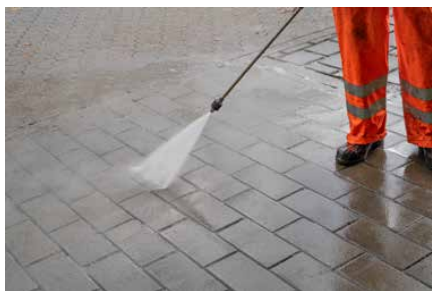
Hochdruckreini- ger mit aus- reichendem Ab- stand einsetzen.
