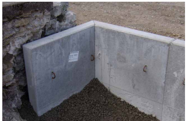
Bild 31: Versetzte Eckelemente
