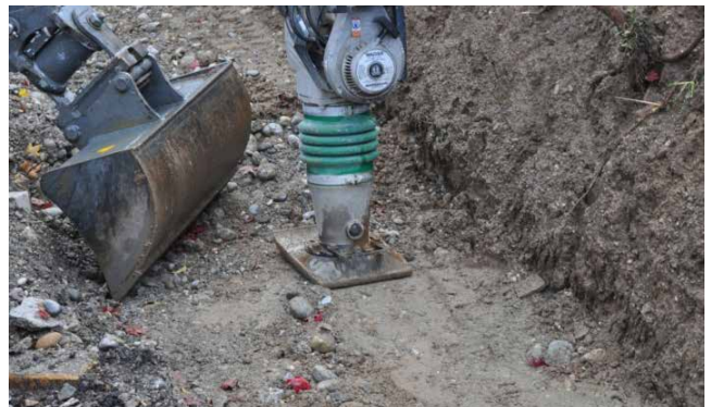
Bild 26: Erstellen der Sauberkeitsschicht
