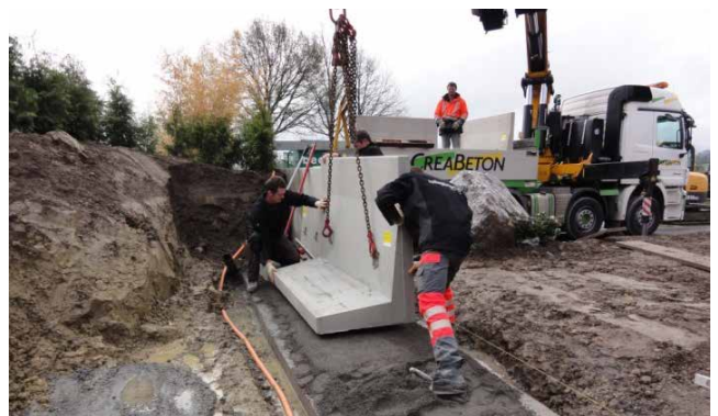
Bild 29: Versetzen der Winkelplatte auf ein Streifenfundament
