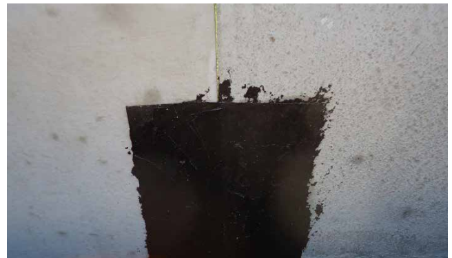
Bild 33: Abdichten der Fugen
