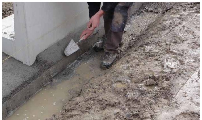
Bild 30: Erstellen der Fundamentnocken
