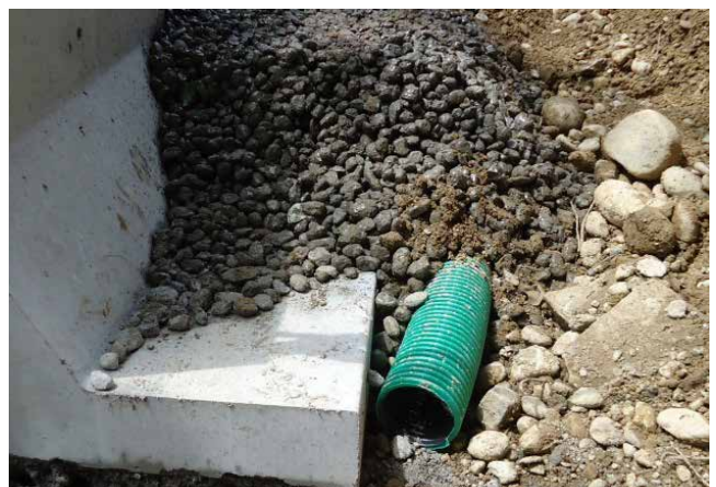
Bild 28: Einbau einer Sickerleitung mit Sickerpackung
