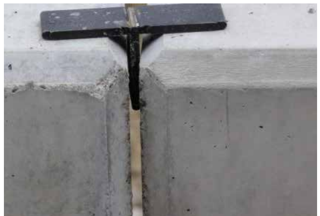
Bild 32: Optimale Fugen nach der Versetzung
