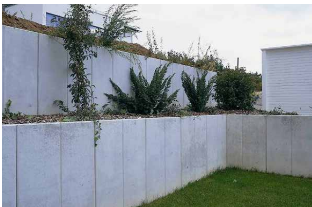
Bild 1: EXACTA® Winkelplatten als Böschungssicherung
