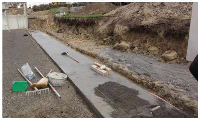
Bild 27: Erstelltes Streifenfundament
