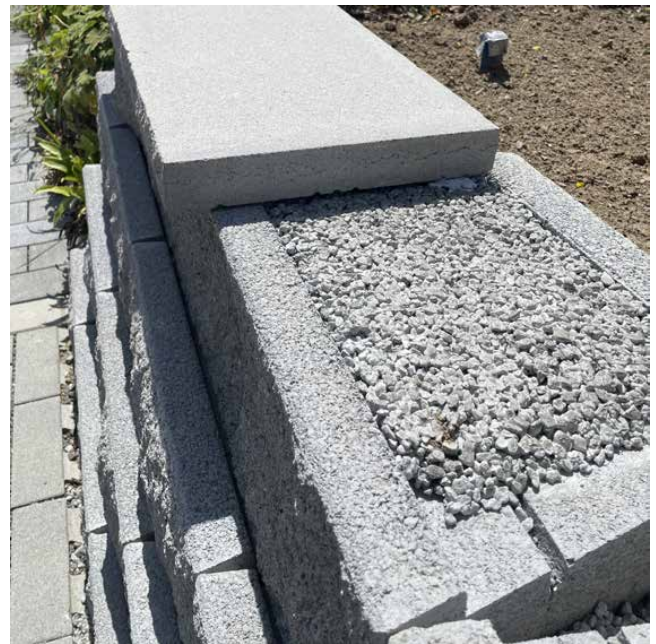
Bild 19: Versetzen von Abdeckplatten
