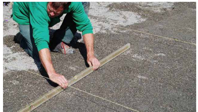
Abziehen der Bettungsschicht
