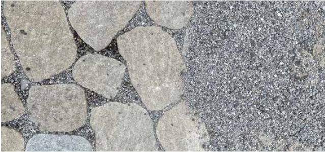
Einsanden der Fugen
