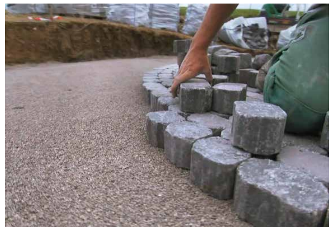
ARENA Vista® Pflastersteine werden von Hand verlegt
