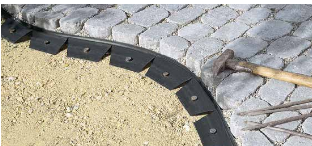
Randabschluss mit PAVE EDGE® Randschienen
