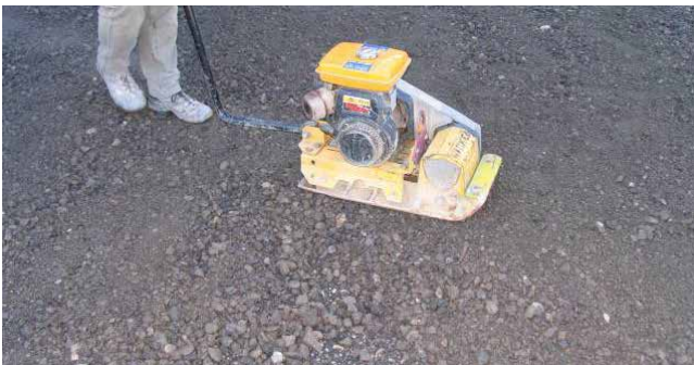
Verdichten der Fundationsschicht
