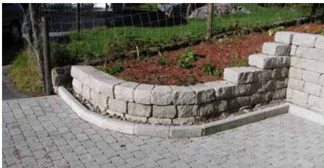
Bild 30: Maueraufbau mit SANTURO® Keilmauersteinen
