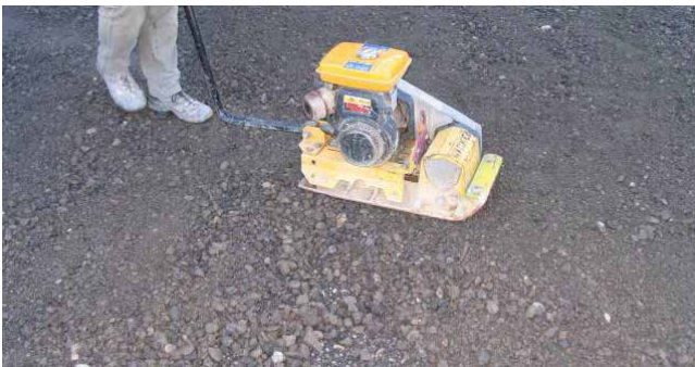
Verdichten der Fundationsschicht
