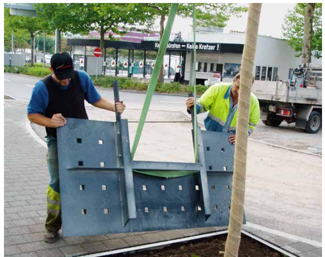
Transport der COPAL® STEEL Stahlbaumscheibe
