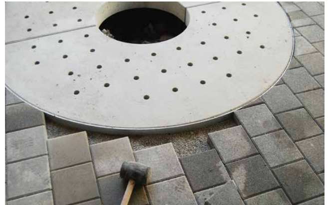
Versetzte TREETUB Betonabdeckung 2-teilig
