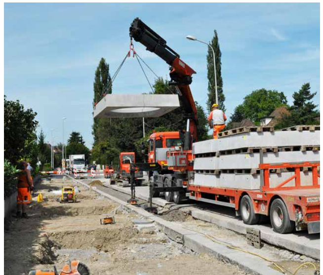
Transport auf der Baustelle mit Lieferfahrzeug
