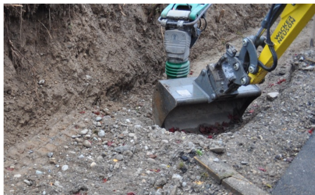
Bild 20: Erstellen der Sauberkeitsschicht
