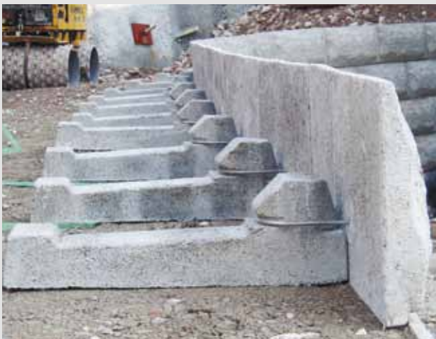
Frontplatten mit Erdanker
