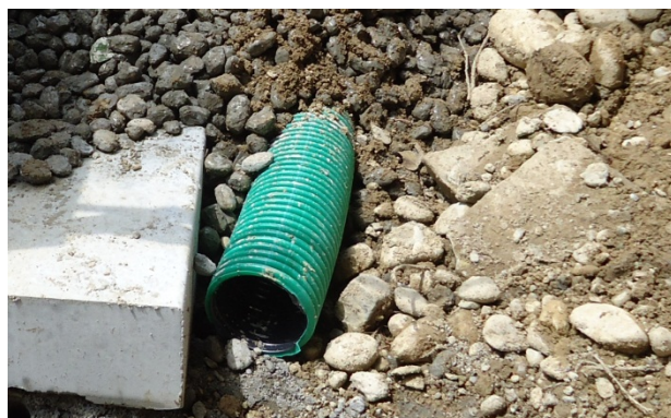
Bild 22: Einbau einer Sickerleitung
