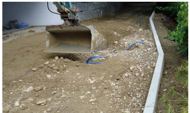
Bild 34: Lagenweises Einbringen von geeigneten Hinterfüllmaterial
