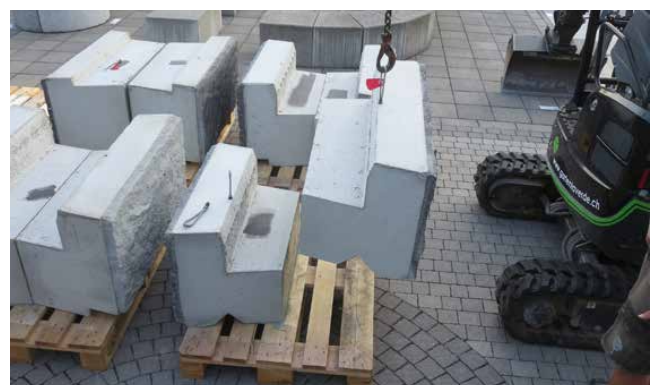
Bild 21 Werkseitig eingebaute Transporthülsen M16
