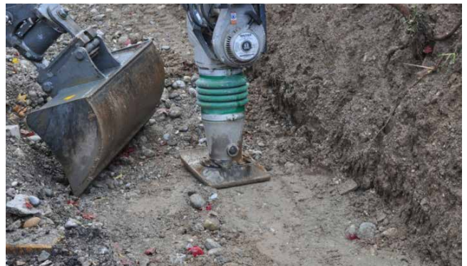
Bild 26: Erstellen der Sauberkeitsschicht
