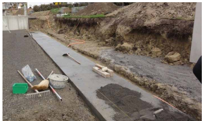
Bild 27: Erstelltes Streifenfundament
