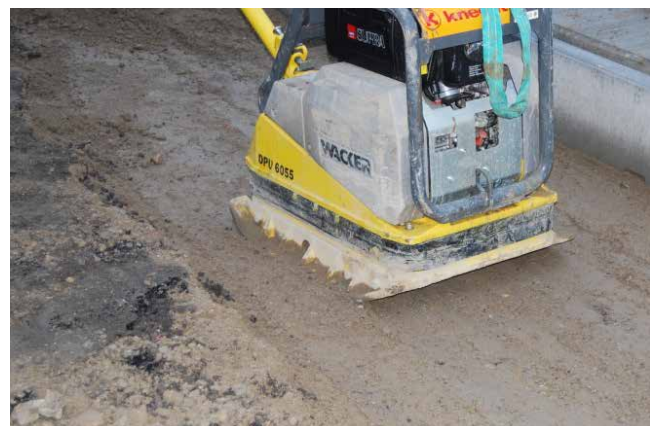
Bild 35: Verdichten nur mit leichten Verdichtungsgeräten
