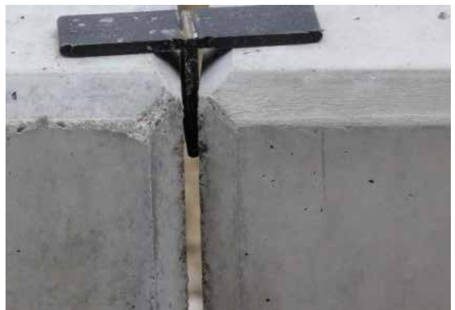
Bild 32: Optimale Fugen nach der Versetzung
