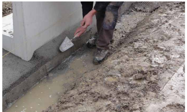
Bild 30: Erstellen der Fundamentnocken
