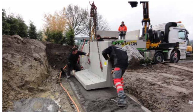
Bild 29: Versetzen der Winkelplatte auf ein Streifenfundament
