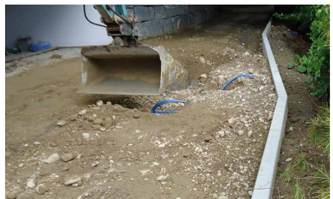
Bild 34: Lagenweises Einbringen von geeignetem Hinterfüllmaterial
