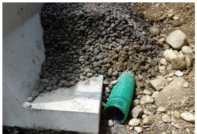
Bild 28: Einbau einer Sickerleitung mit Sickerpackung
