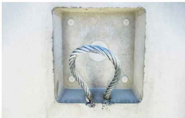
Bild 24: Werkseitig eingebaute Versetzschlaufen
