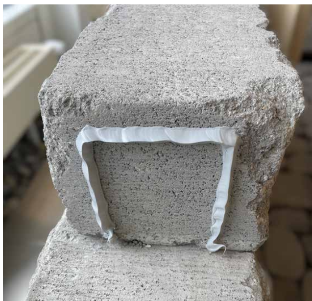
Bild 2: Verkleben und Abdichten der Stossflächen
