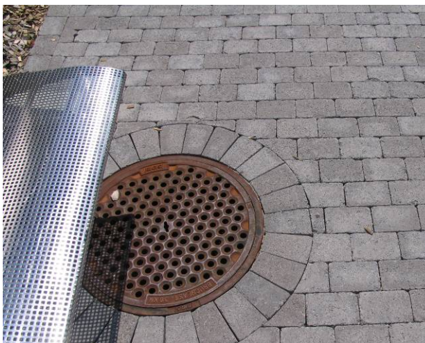
Bild 42: Anpassung bei Schachtabdeckung
