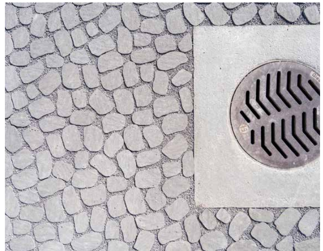
Bild 3: Einlaufschacht mit Betonkragen
