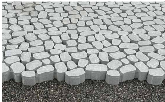
Bild 8: Verlegen von ARENA® Seno Rasensteine
