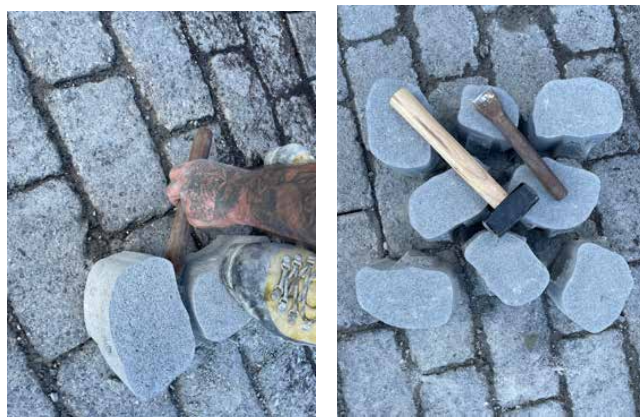
Bild 9: Auftrennen mit Steinsetzer und Fäustel in Einzelstücke
