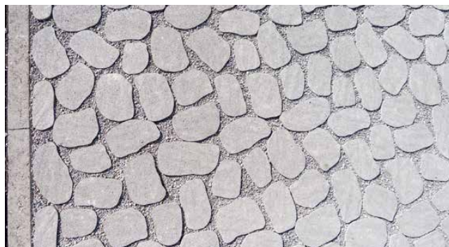
Bild 2: Eingesetzte Randstein entlang Stellplatten
