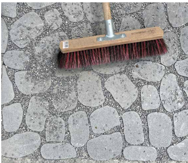
Bild 6: Einsanden der Fugen
