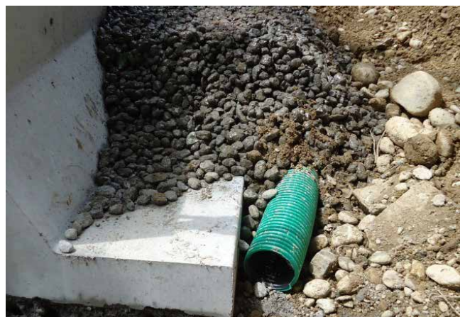
Bild 28: Einbau einer Sickerleitung mit Sickerpackung
