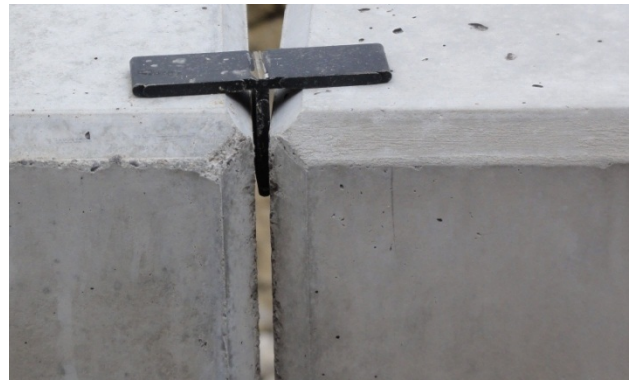
Bild 27: Optimale Fugen nach der Versetzung
