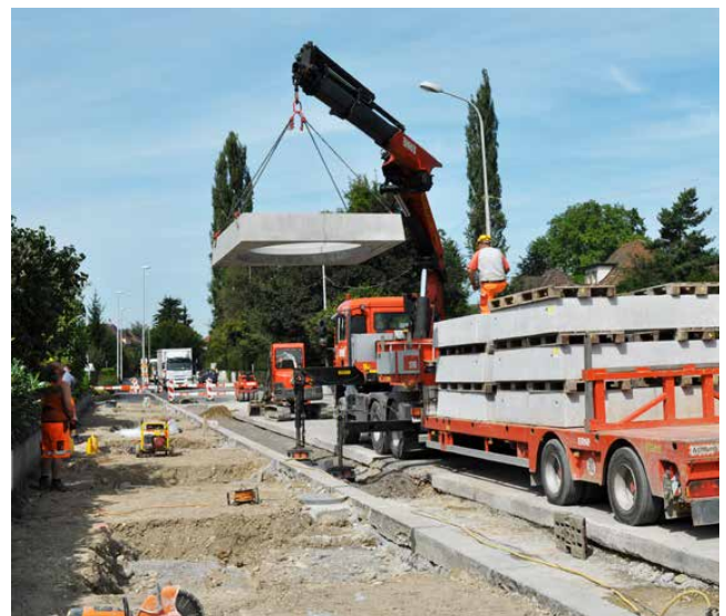
Transport auf der Baustelle mit Lieferfahrzeug
