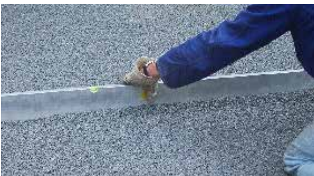
Bild 6: Bettungsschicht abziehen
