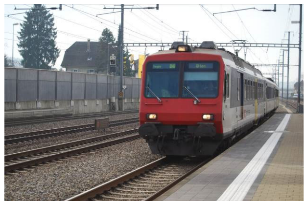
Bild 38: Bahnplattform mit eingebauten CARENA® Sicherheitsliniensteinen H = 6 cm
