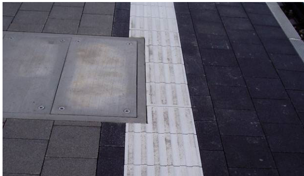
Bild 30: Anpassungen der CARENA® Sicherheitsliniensteine bei Schachtabdeckungen
