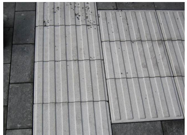
Bild 34: Optimale Fugen bei Steinen H = 8 cm
