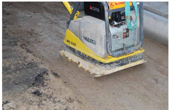
Bild 35: Verdichten nur mit leichten Verdichtungsgeräten
